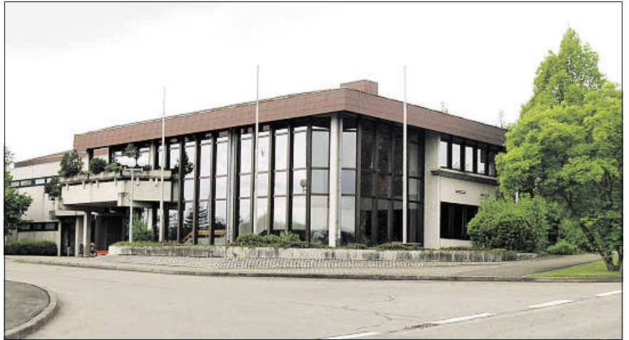
Eimer raus, der Regen kommt: Auf eine Teilsanierung für das undichte Flachdach und die Oberlichter der Halle des Dorfgemeinschaftshauses einigte sich nun der Bempflinger Gemeinderat. Foto: rg
